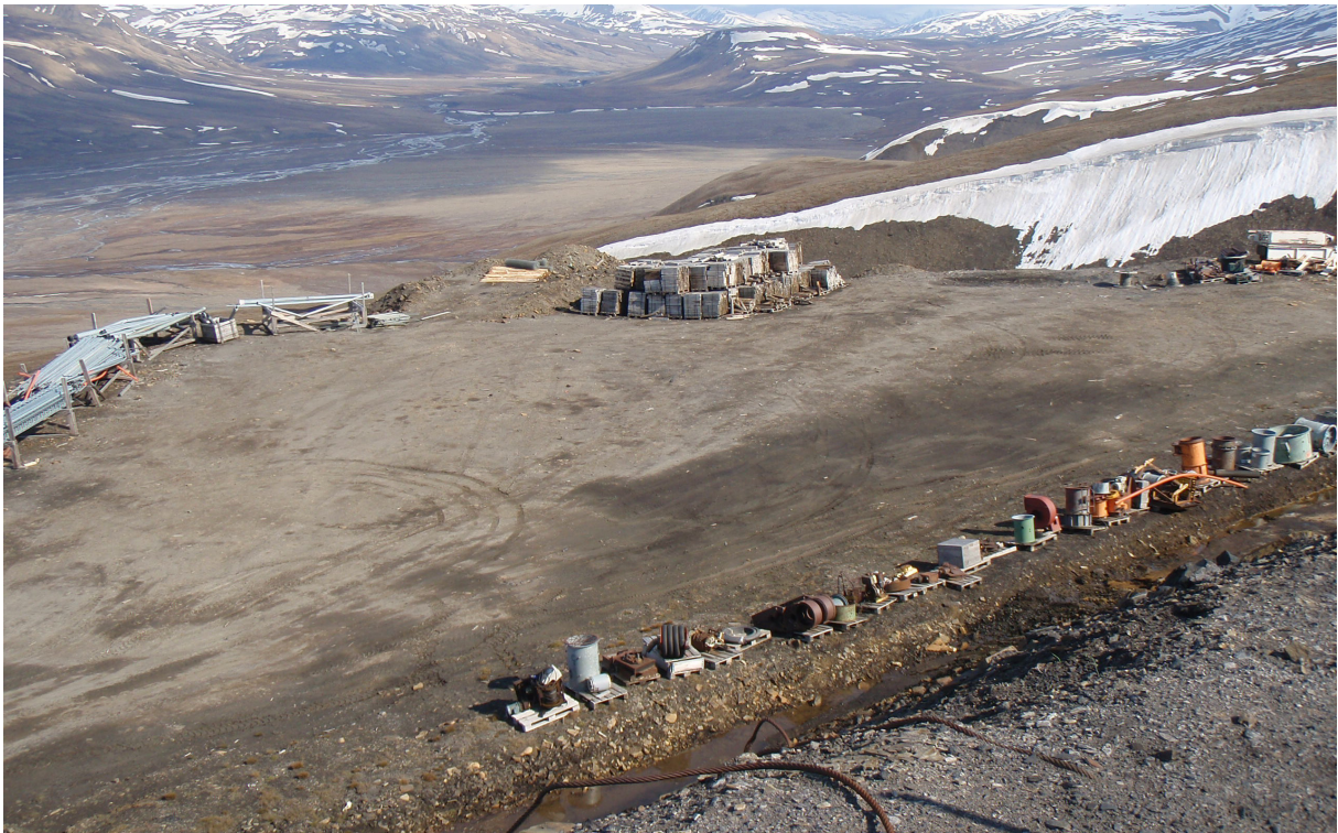
Figur 8: Deponi/avfallsfylling ved Gruve 7
