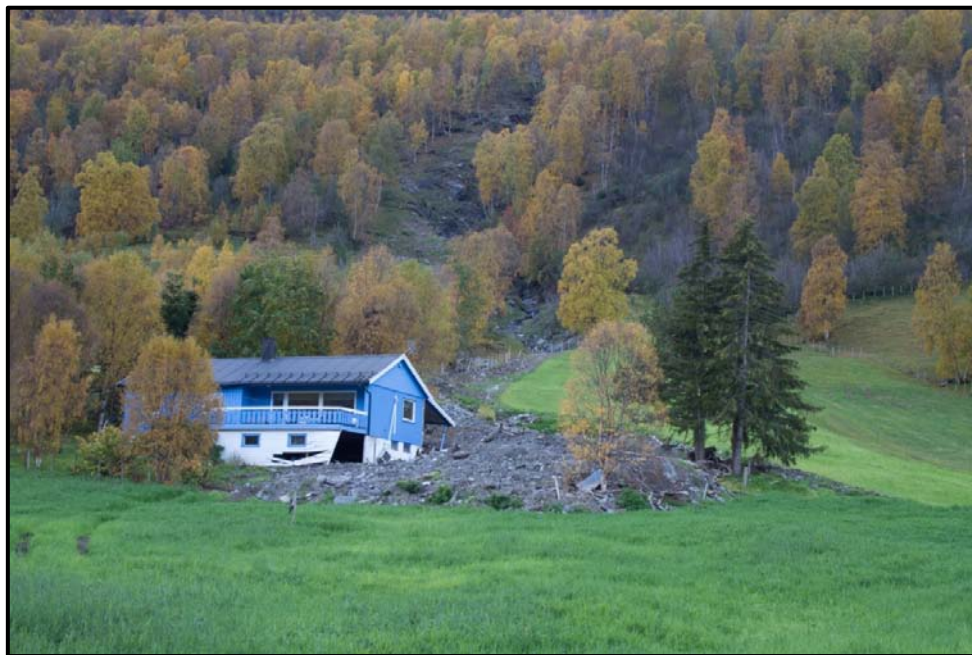
Figur 15. Skredavsetninger etter sørpeskredet som gikk i mai 2010. Bekkeløpet i bakgrunnen hvor sørpeskredet kom fra (Storelva). Skredmassene lenger ned på vifta (nå dekket av gress nederst på bildet) er delvis fjernet og planert ut i ettertid.
