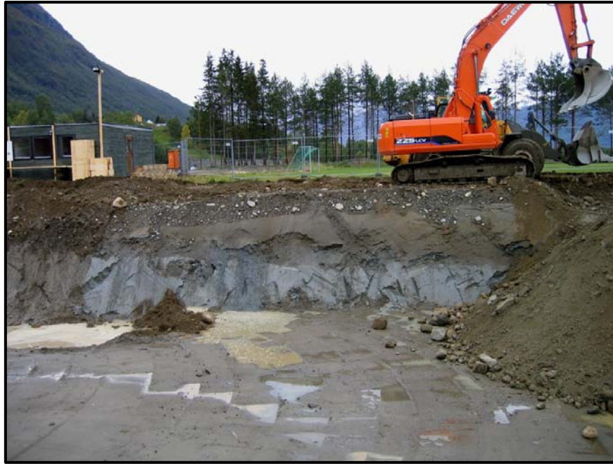
Figur 10. Havavsetninger (leirig silt) som ligger under elveavsetninger på toppen (grusig sand). Bildet er tatt ved skolen.
