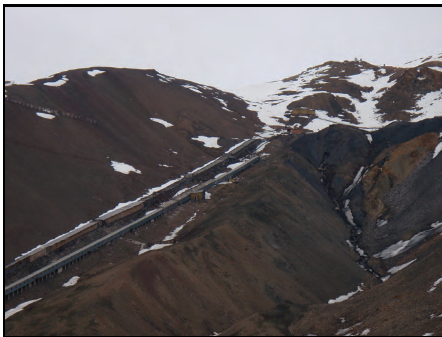
Figur 28. Bygninger og jord oppover fjellsiden ved Pyramiden er PCB-forurenset.
