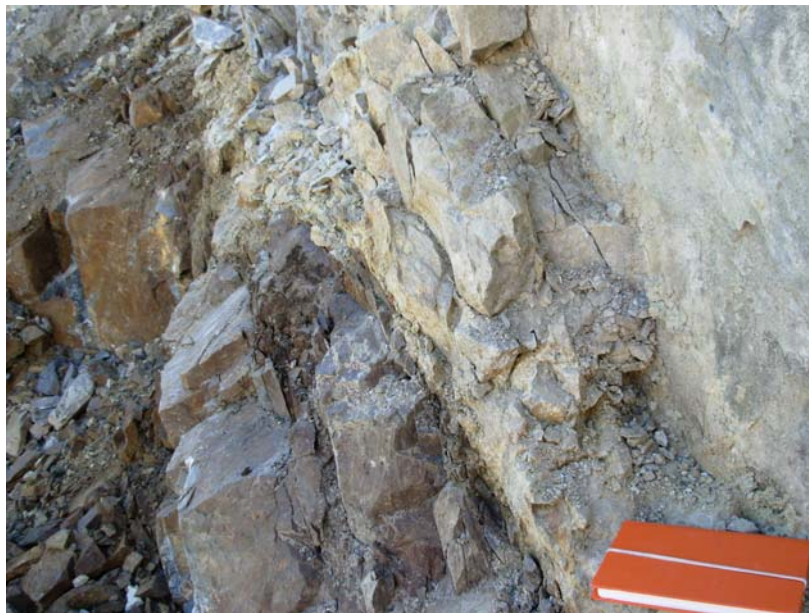
Figur 11. Diabasgang (til venstre) orientert 165/85 med en sterkt oppkjust, leirmineralrik og forvitret forkastnings-/skjærpåvirket grense (lokalitet 20).
