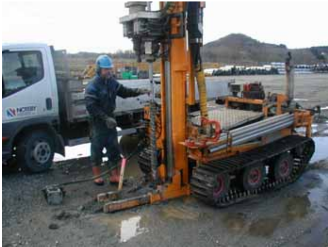
Figur 2 Skovlboring med innsamling av prøve for hver meter inntil 3 meters dybde.
