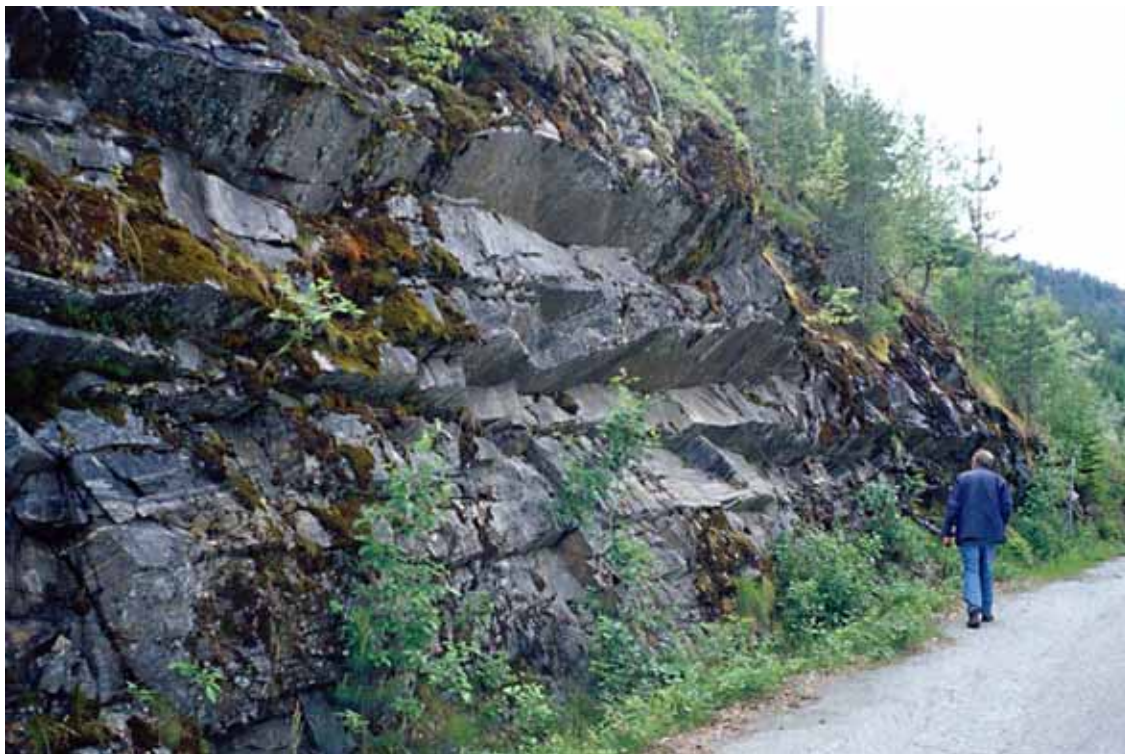
Figur 16 Veiskjæring ved Halsan i Krøderen, der amfibolittisk gneis, viser subparallel oppsprekking.
