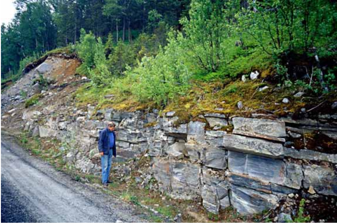
Figur 11 Veiskjæring langs Mælåsen med partier der oppsprekningen kan være egnet for muresteinsproduksjon.
