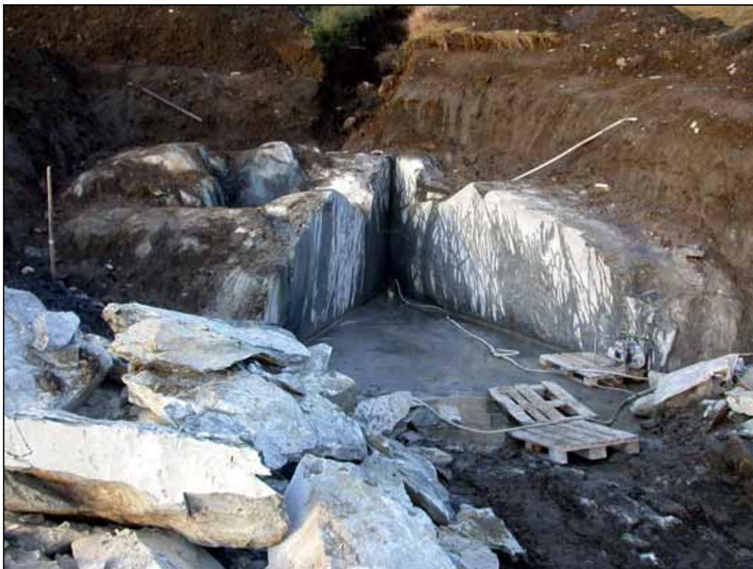
Figur 13 Oversiktsbilde av blokkuttak i område B, sett mot vest. Uttatte blokker til venstre på bildet er sprukket opp langs talkårer/mikrosprekker.
