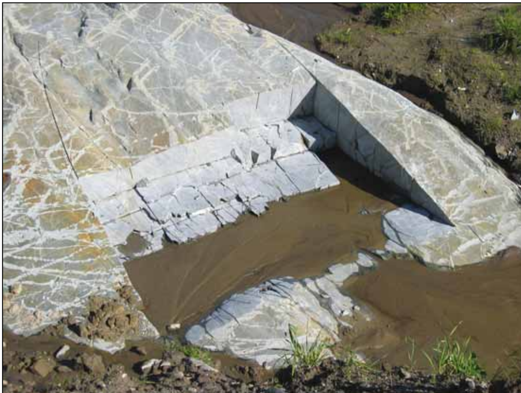
Figur 11 Blokkuttak i område A, sett mot nordøst. Lyse striper skyldes skraping fra gravemaskin.
