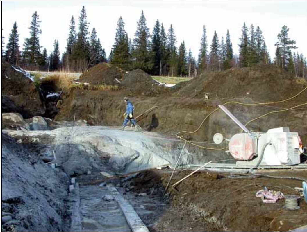
Figur 12 Blokkuttak med wire-sag, område B, sett mot vest.
