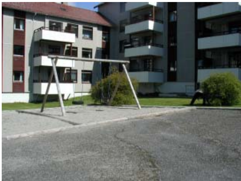
Figur 12. Lekeklassen ved Erleveien borettslag.
