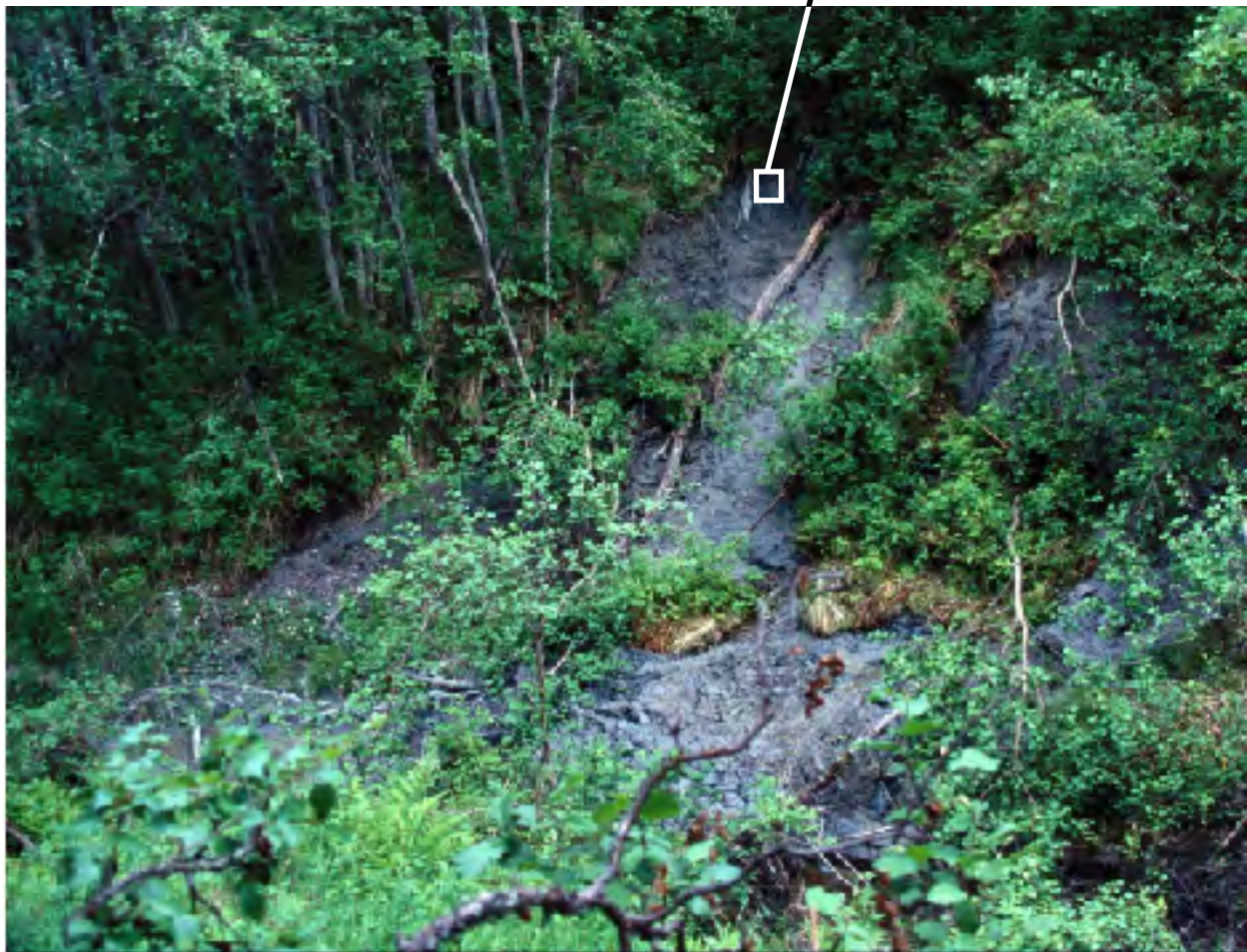
Figur 12. Grunn utrasning ved lokalitet A02. Grunnvannet siger ut av bakken gjennom lag av finsand, som forårsaker erosjon av både sand og leire. Plassering av lokaliteten, se Fig. 10.
