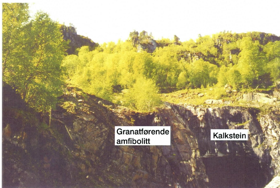
Figur 3 Området fra tunnelåpningen og opp til vanndele, mot Nås.
