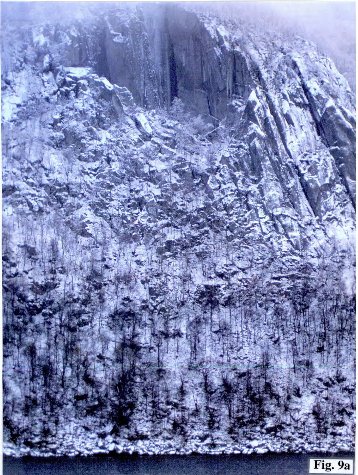
Fig. 9. a) Utglidning (ca. 50 m bred) like øst for Kjeupsa vest for Geiskeli, sørsida av Fedafjorden (sed Vedlegg 3). b) Bueformet forsenkning formet som resultat av en utglidning ved østlige del av Skagelistranda, sørsida av Fedafjorden (se Vedlegg 4). c) Begynnende utglidning ved Odreholet nord for Domkjørkkneben, sørsida av Fedafjorden (se Vedlegg 4).
