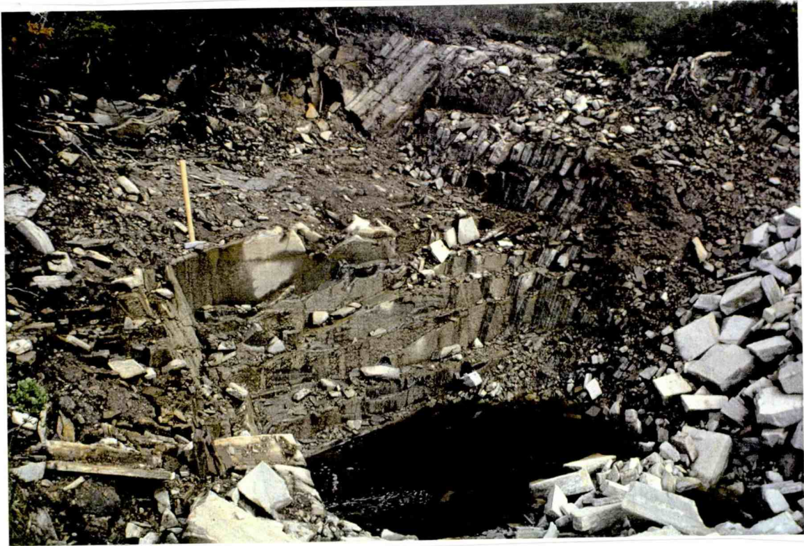
Figur 2 Forsøksbrudd, sprekke utviklingen sees tydelig
