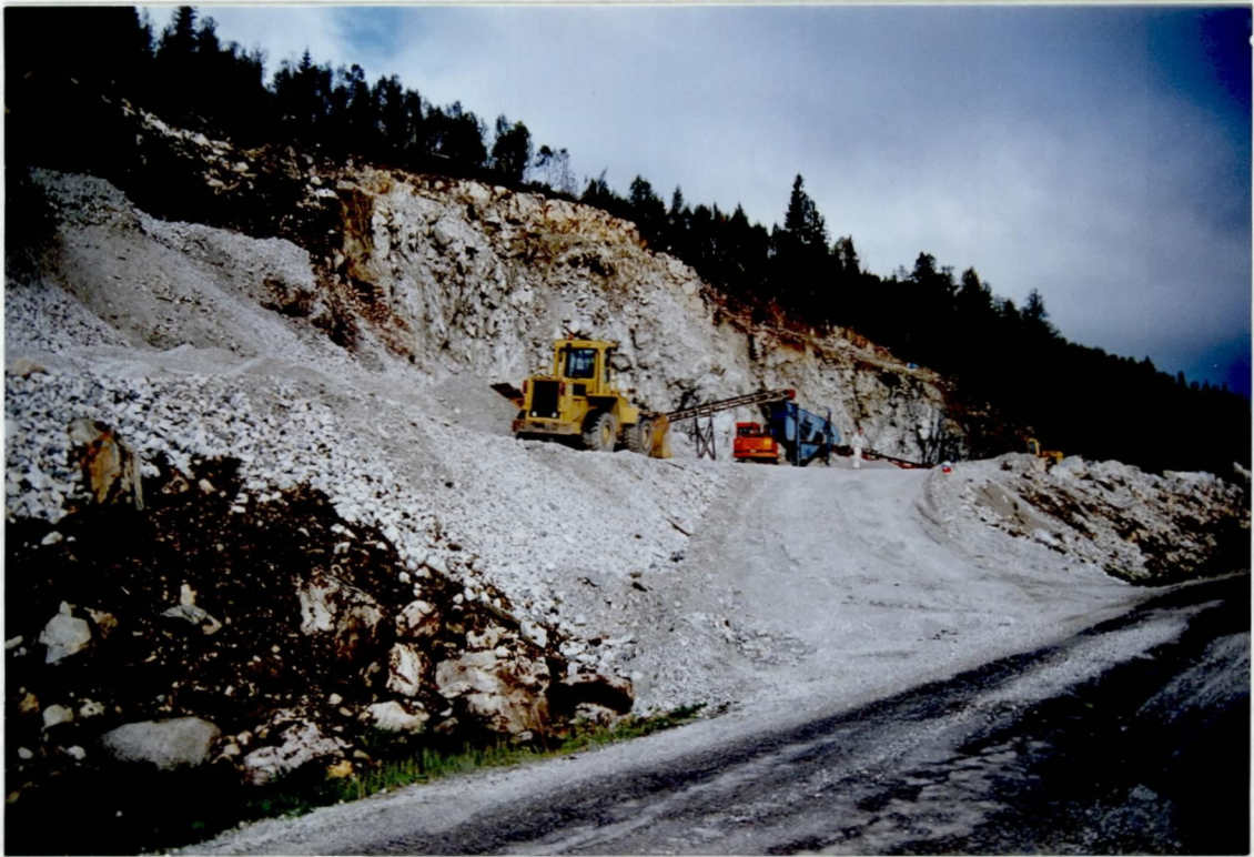
Fig. 2. Pukkverket ved Urda sett mot nord.
