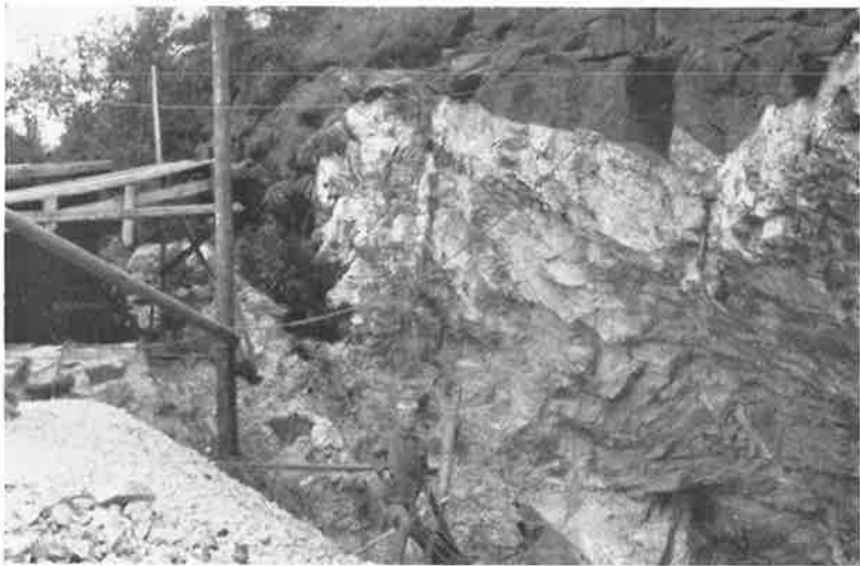
Fig. 62. Feltspatbrudd ved Kibbevik på Askerøen ved Lyngør. Pegmatiten danner en skråttliggende linse. På bildet sees litt av pegmatitlinsens øverste del med overliggende mørk gabbro.
