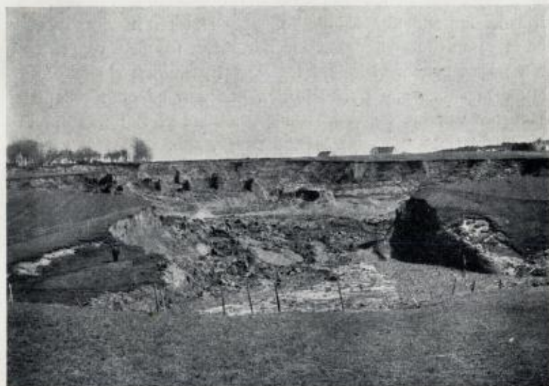
Fig. 6. Utløpsporten for lerfaldet ved Gretnes.
