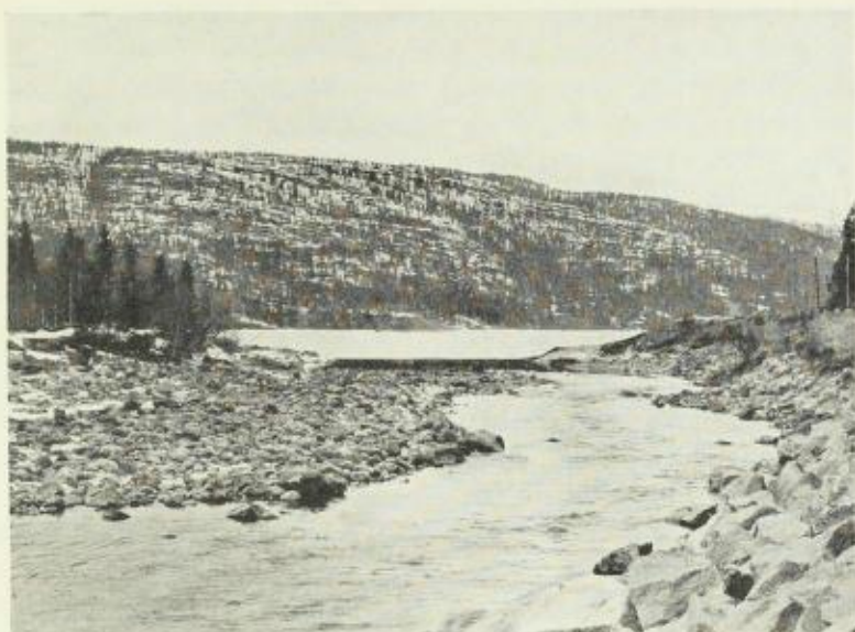
Fig. 12. Elven fra Grungstadvatnet sett opover. Den tørre elveseng til venstre. Til høire elvebruddet og det nye far.
