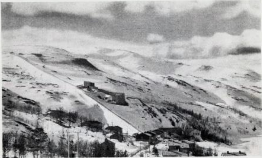
Fig. 6. Skorovas gruve, sett mot vest-sydvest. Heisbanen går på skrå opp fjellsiden til grunnstollens inngang. Til venstre for heisbanen sees den tydelige benkning i grønnskifer og tufflag. Søndre Grønndalsfjells gabbromassiv sees i bakgrunnen fra fjelltoppen midt på bildet og fjellryggen ned til høyre.
