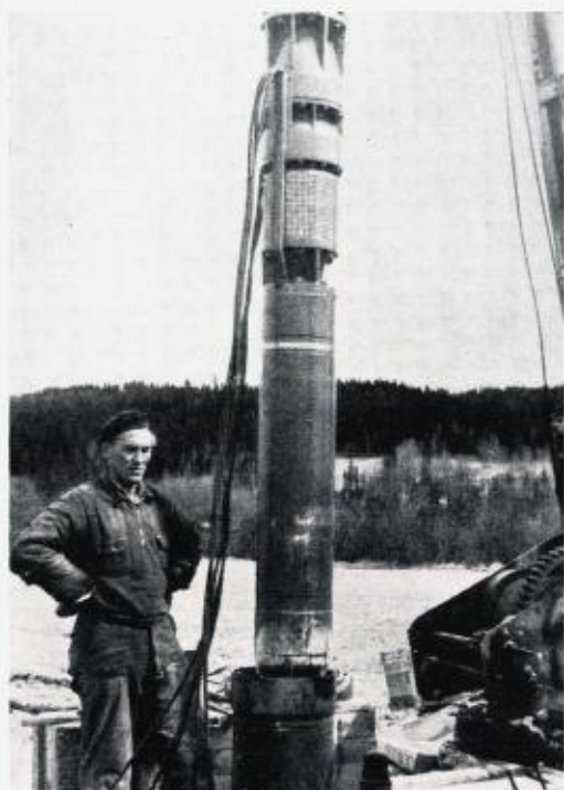
Fig. 7. Nedsenking av seentrifugalpumpe. Eggen fot.
