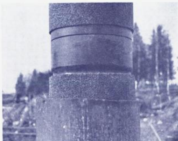
Fig. 6. Filteret settes ned i jorddrivingsrøret. Eggen fot.
