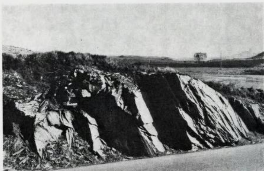
Fig. 2. Frisk veiskjæring i grønnskifer. Riksvei 14 øst for Torvastad. New road cut in greenschist. Highway 14 east of Torvastad.
