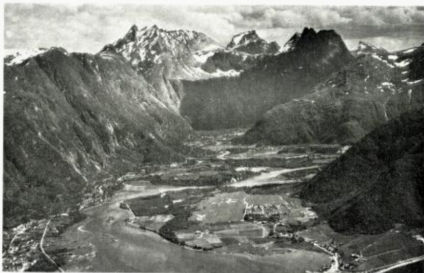
Fig. 19. Nedre del av Romsdalen. Veblungsnes i nederste, høyre hjørne. I nederste, venstre hjørne sees litt av tettbebyggelsen på Åndalsnes. Ved dalinnsnevringen midt på bildet ligger Sogge, og midt på bildet til høyre munner Isterdalen ut i Romsdalen. De kjempestore terrassene ved Isterdalens munning er ikke med på bildet. Soggemoen midt på bildet til høyre (foran dalneset). Setnesmoen i forgrunnen omlag midt på bildet. The lower part of Romsdalen. Veblungsnes at lower right; part of Åndalsnes lower left. Sogge lies in the narrow part of the main valley in the centre of the picture. The lowermost part of Isterdalen is seen to right of centre. Soggemoen is the flat area at the confluence of the two valleys. The flat area in the centre foreground is Setnesmoen.
