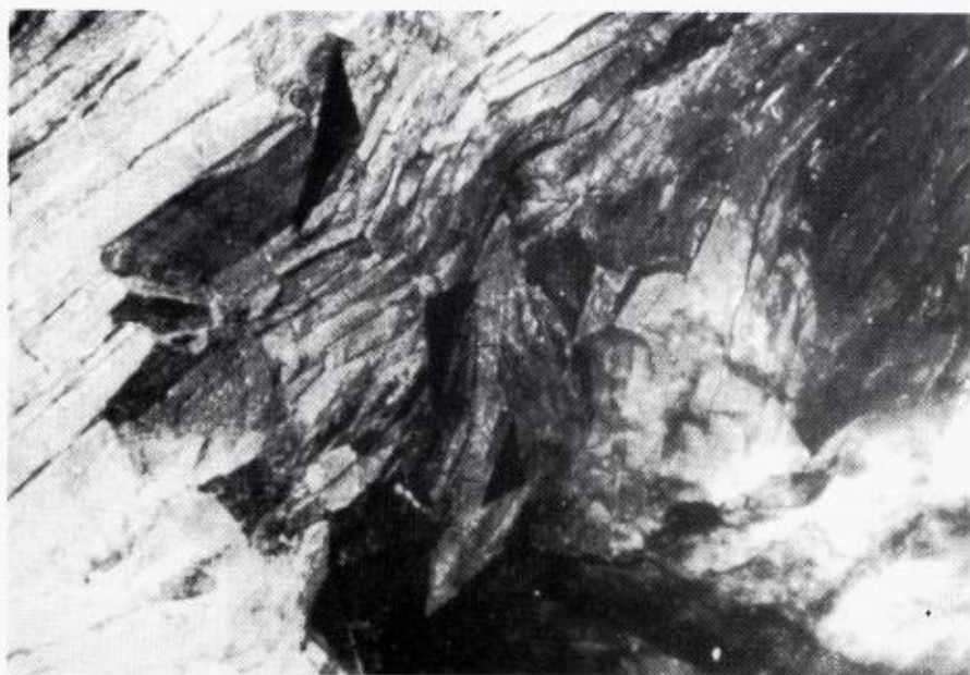
Fig. 4. Utknekkning av helleskifer p.g.a. høye spenninger. (Driva Kraftverk, Sør-Trøndelag Kraftselskap).
