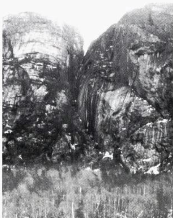
Fig. 8. Markert svakhetssone tvers på dalsiden i Sirdalen. I en tunnel som krysset svakhetssonen ca. 300 meter under dens utgående i dagen fikk en meget store utrasninger.
