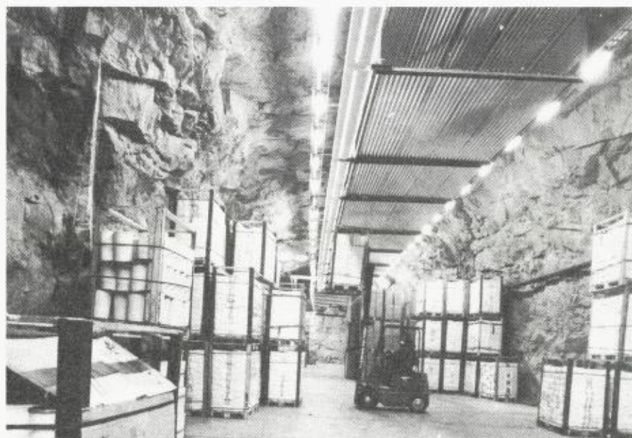
Fig. 2. Lagerhall for iskrem. Vegger og tak er bare sporadisk sikret med bolter. Lagringstemperaturen er ca. + 25^{\circ}\text{C} . Fjellmassen rundt virker som kuldelager og hindrer store temperaturfall i hallen. (Diplom-Is, Oslo).
