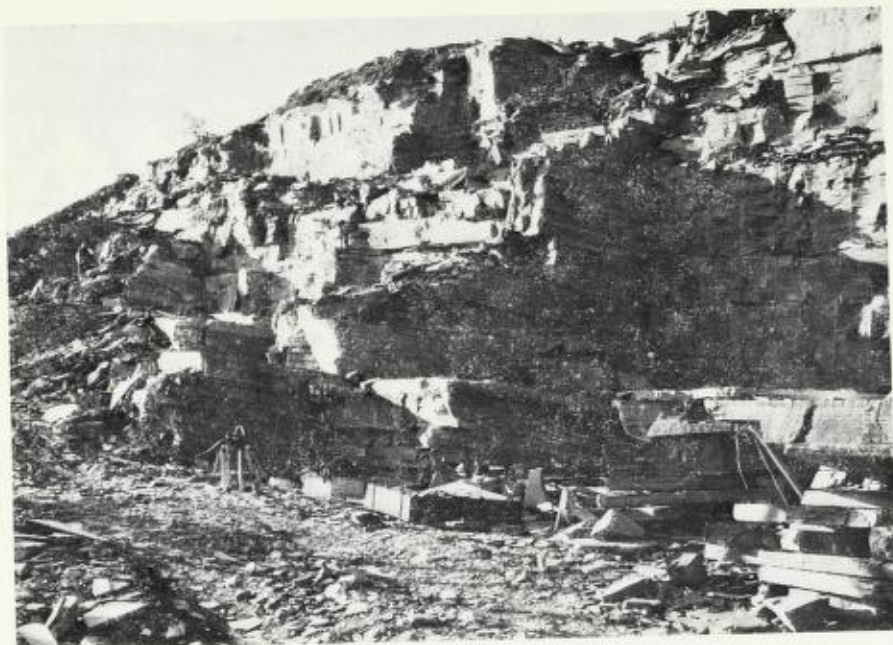
Fig. 15. Skiferbrudd med tradisjonell drift. Storhalla, Peska (882508). Foto, O. Øvereng 1971.
