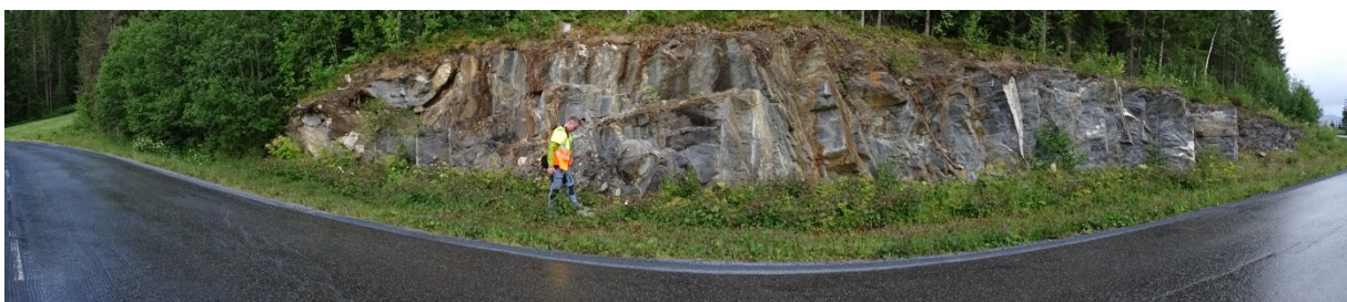
Figur 58 Vegskjæring vest for Sunnan. Foto: A. Raaness
