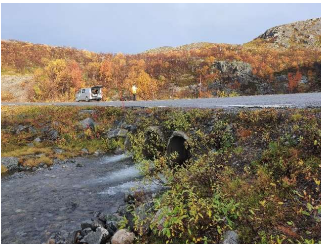
Figur 3.6.37: Uttakspunkt («Grunnvannslokalitet») 37 i elv med utløp til Holmvatnet på Jarfjordfjellet. (Kart; se Figur 3.6.26a).
