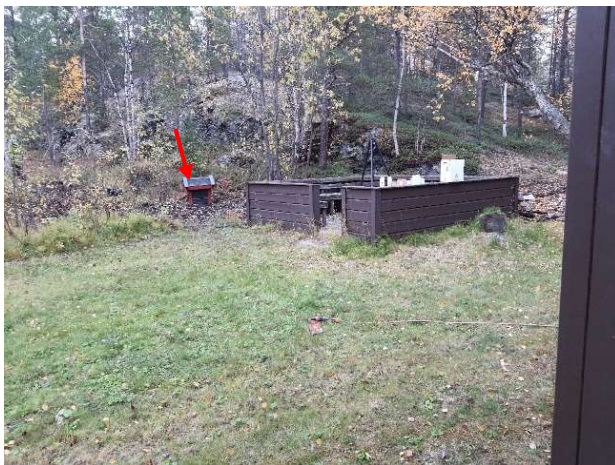
Figur 3.6.20: Grunnvannskilde 20. Boret brønn i fjell.
