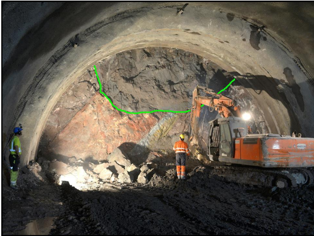
Figur 10.9: Løsmasser (over den grønne streken) på tunnelstuppen ved driving av Holmestrandporten. (Foto: Jernbaneverket / Bane NOR).
