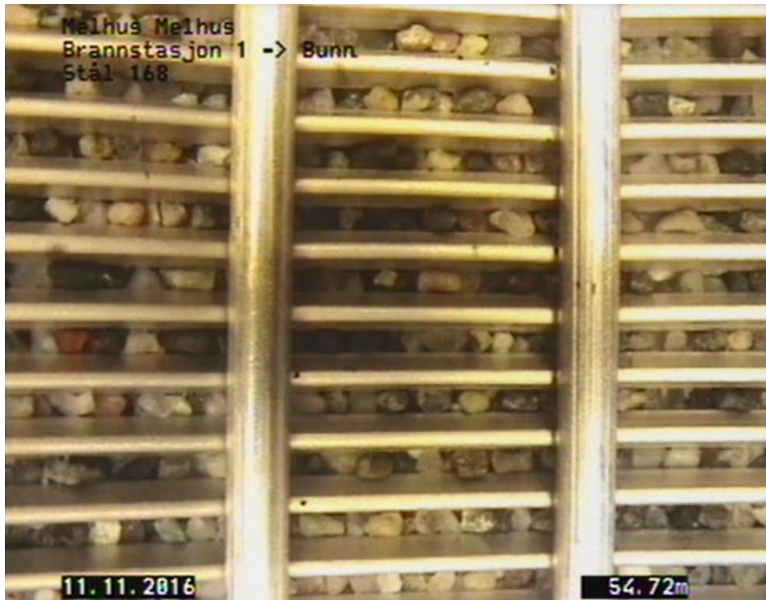
Figur 16. Brønninspeksjon i brønn Brannstasjonen, brønn 1, 54,72 meters dyp. Eksempel på hvordan brønnfilteret bør se ut, uten utfelling eller avleireing. Foto fra Gjøvåg AS.
