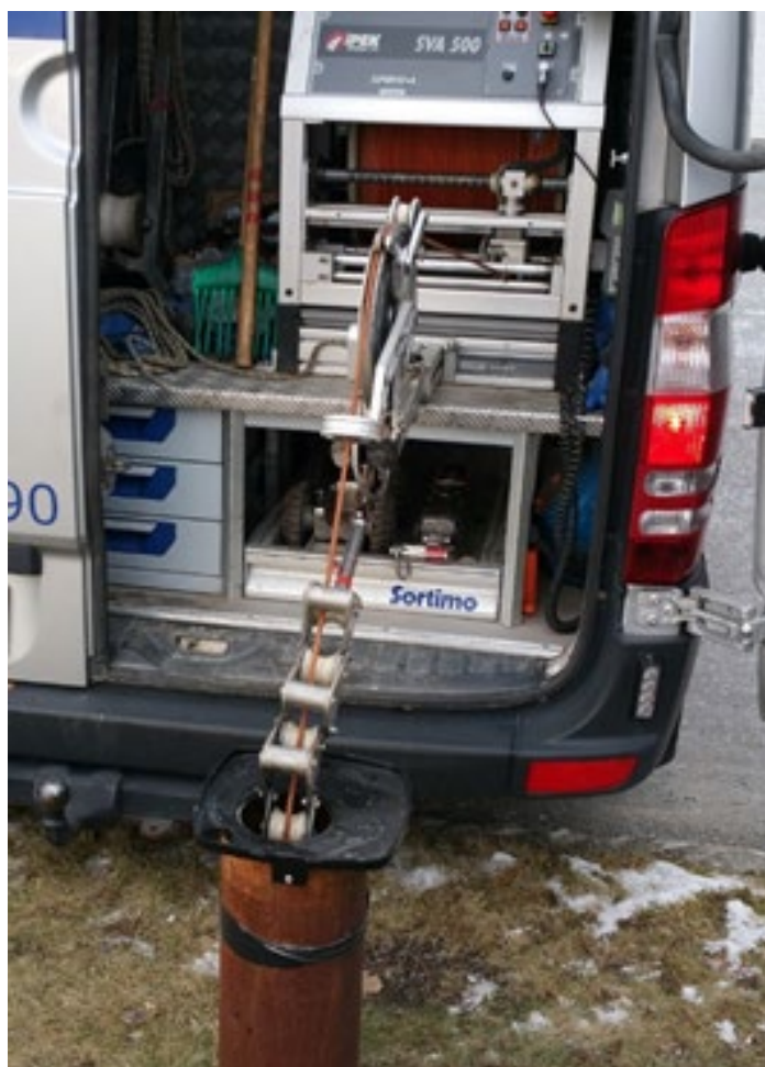
Figur 14. Oppsett for videoinspeksjon av observasjonsbrønn i Melhus utført av Gjølvaag A . S (Foto: Randi Kalskin Ramstad).
